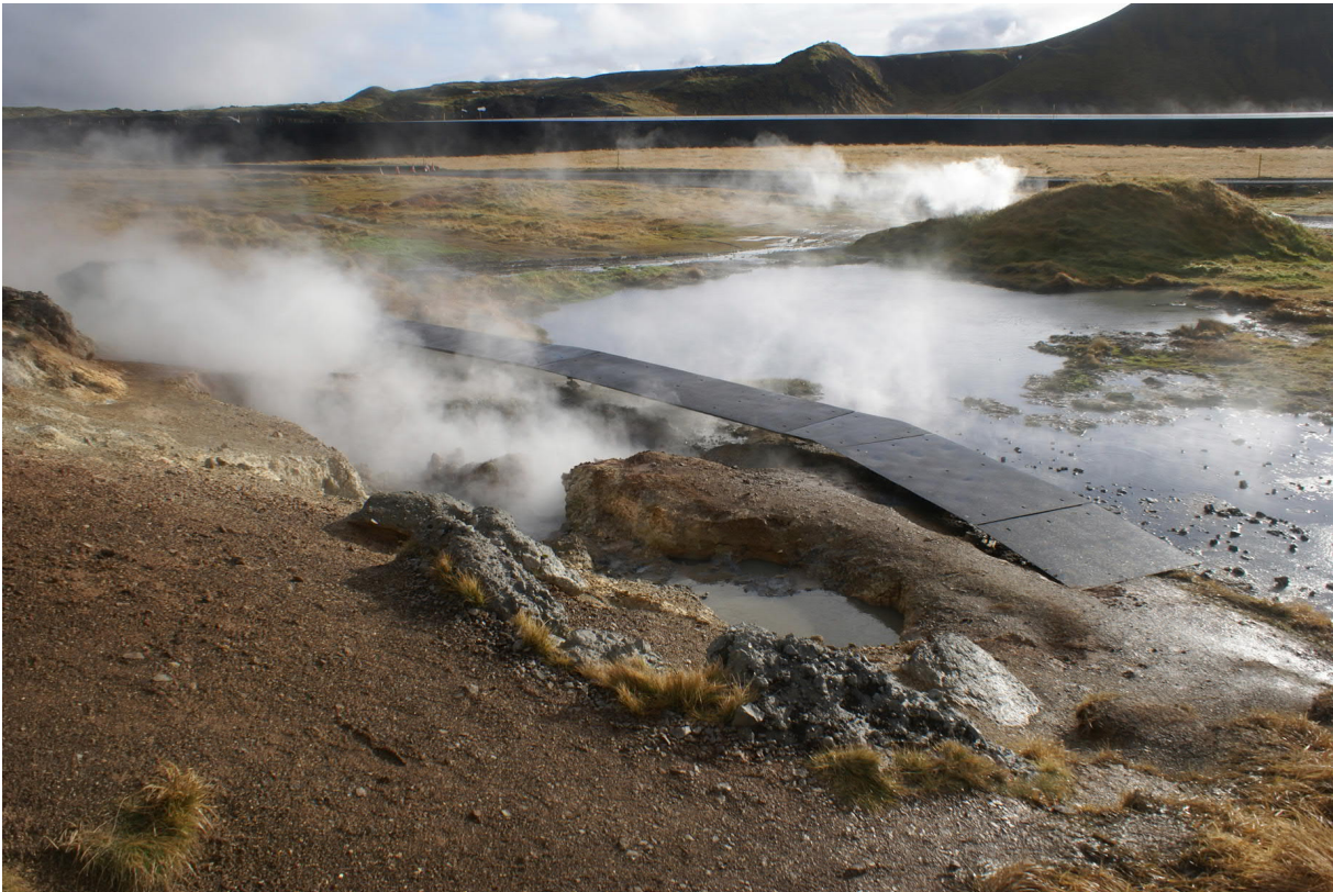
Mynd 4.3 Göngustígar í Hveradölum. Göngubrú er úr áli sem þolir hveragufurnar og hvílir á festingum sem hægt er að fjarlægja þannig að engin ummerki sjást á eftir.
